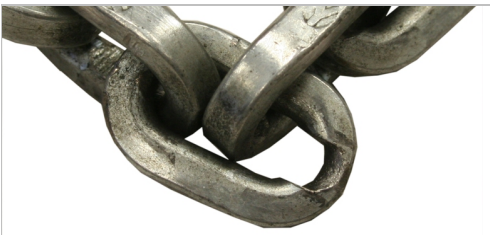
Kjettinglenken er svært slitt.
